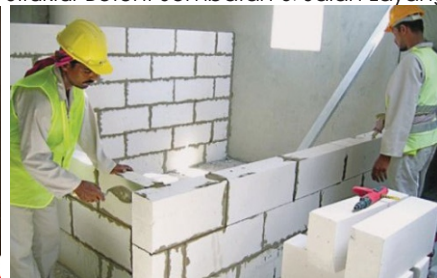
Pekerjaan Bata AAC
