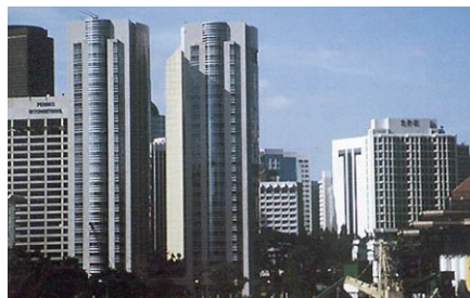
Konstruksi Bangunan Beton
