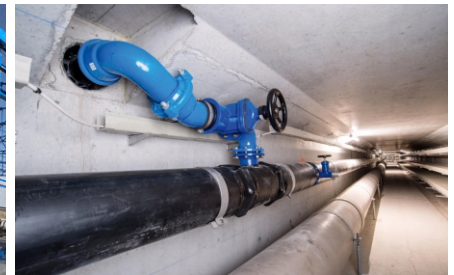
Konstruksi Pipe Ulet
