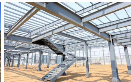
Konstruksi Baja Bangunan
