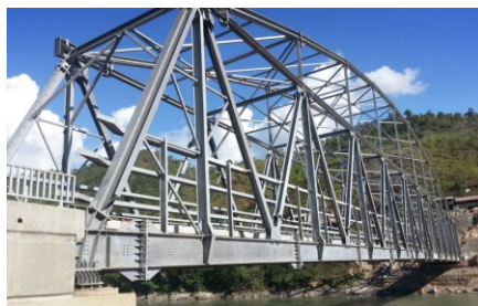
Konstruksi Baja Jembatan
